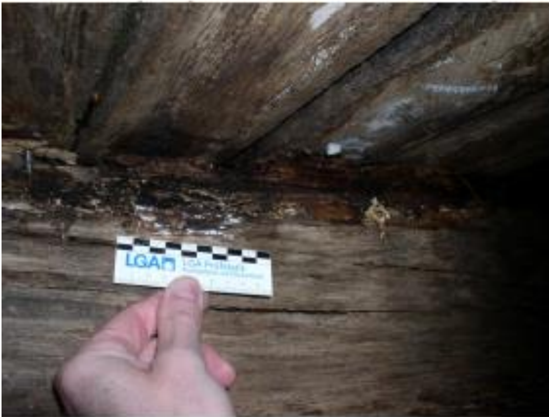
Längsträger bereichsweise angefault
